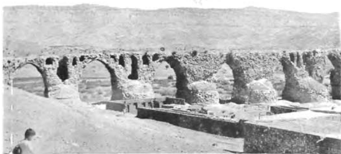
تصویر شماره ۲۶ - طاقهای غربی پل کشکان
