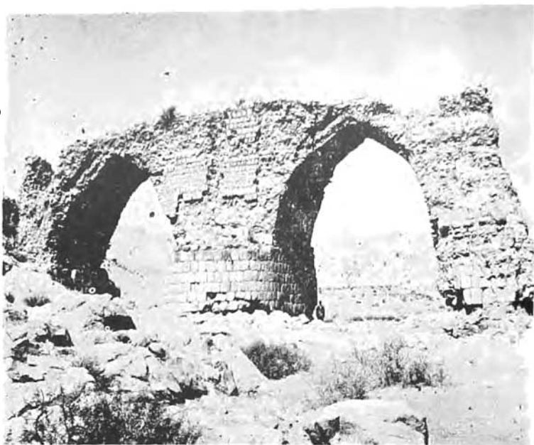
تصویر شماره ۱۸ - دو طاق از پل «کرو دختر» و سطح سنگی زیر بنا
