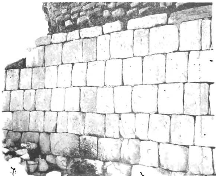
نمایی شماره ۱۹ - سنگهایی که در پایه پل بکار رفته است
