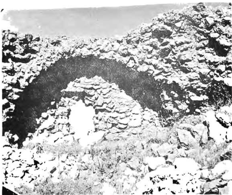
تصویر شماره ۷۷ - دیوار یکی از طاقهای قلعه
