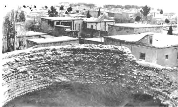
تصویر شماره ۲۰ - قسمتی از دیواره گرداب سنگی خرم آباد
