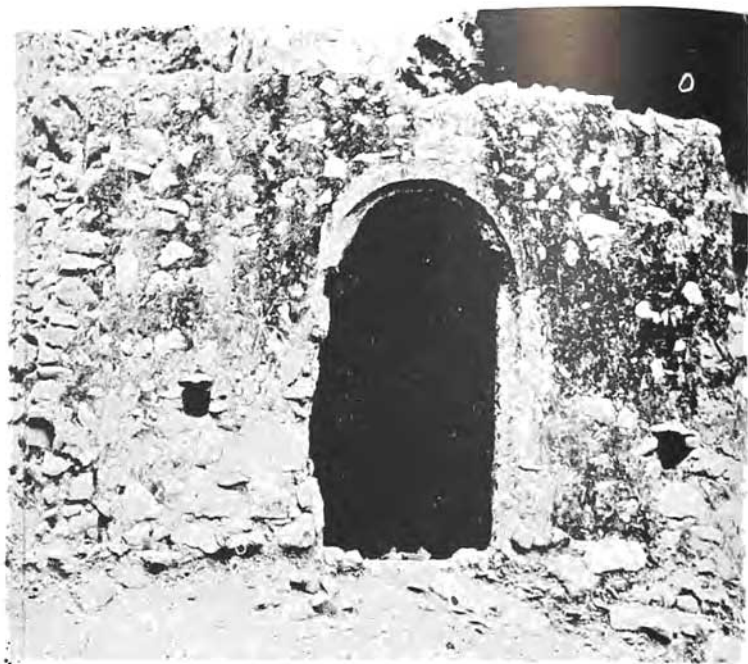
تصویر شماره: ۱۳ - در و دیوار آسیاب تنگه « شیخ ماخو »
