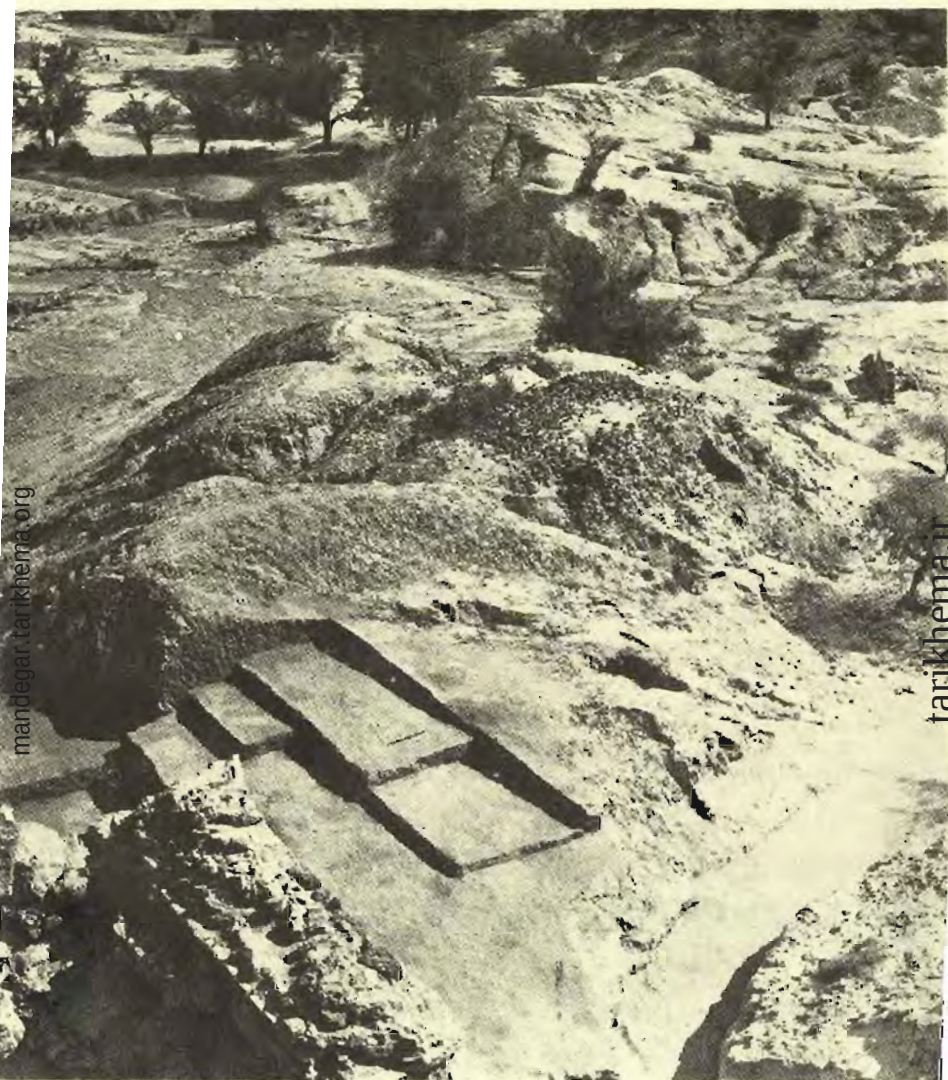
شکل (۱) - نمایش سد «تل بالا» در جزیره قسم که در جریان سیل آبهای بهاری ویران شده و محل حفاری درعکس دیده میشود (عکس از نگارنده)
