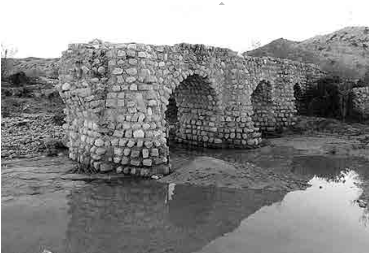
پل بند، لاور خشت و رکن آباد
