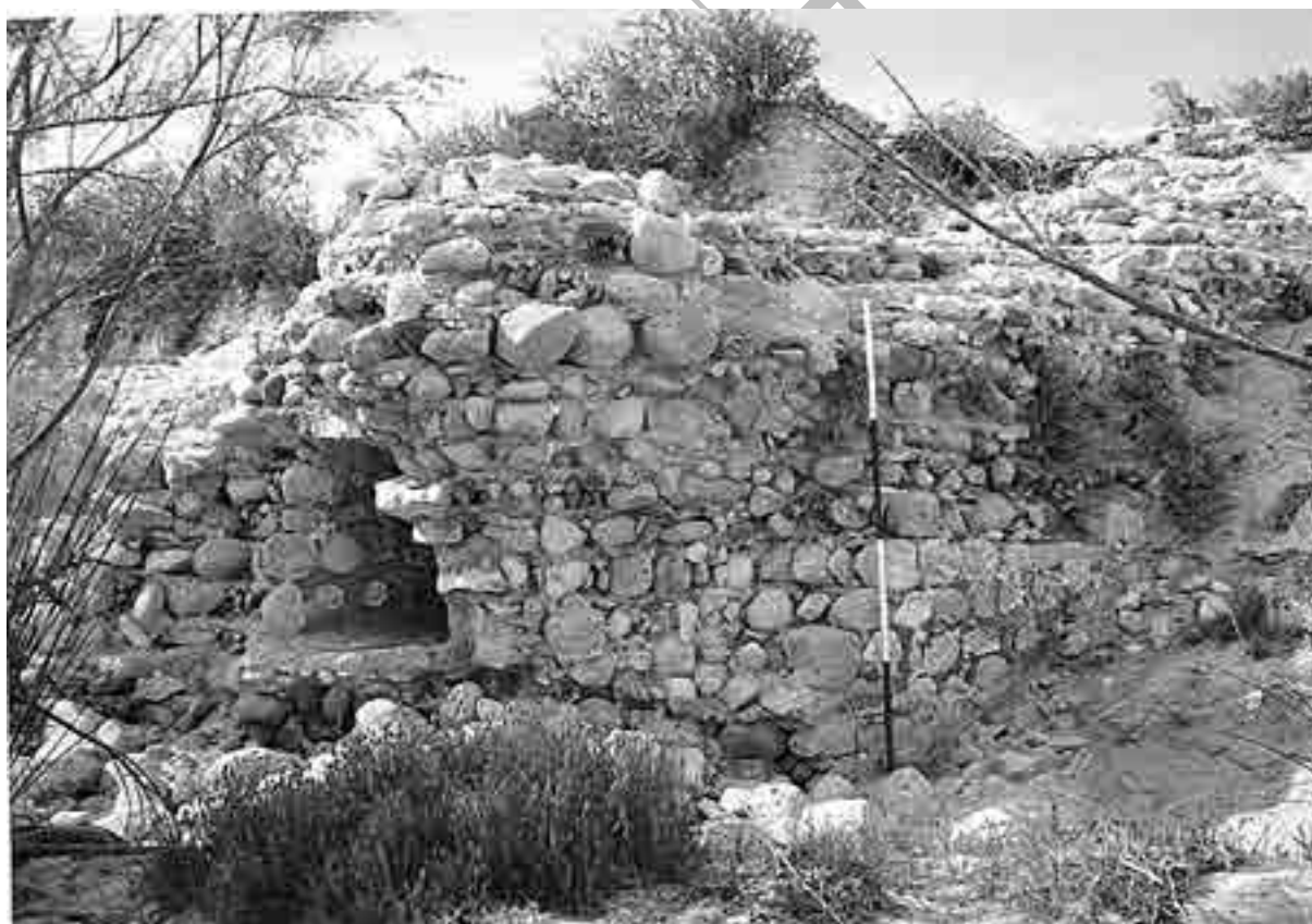
کانال شتر گلو، سازه انتقال آب، فخرابی ظالمی. علامرودشت
