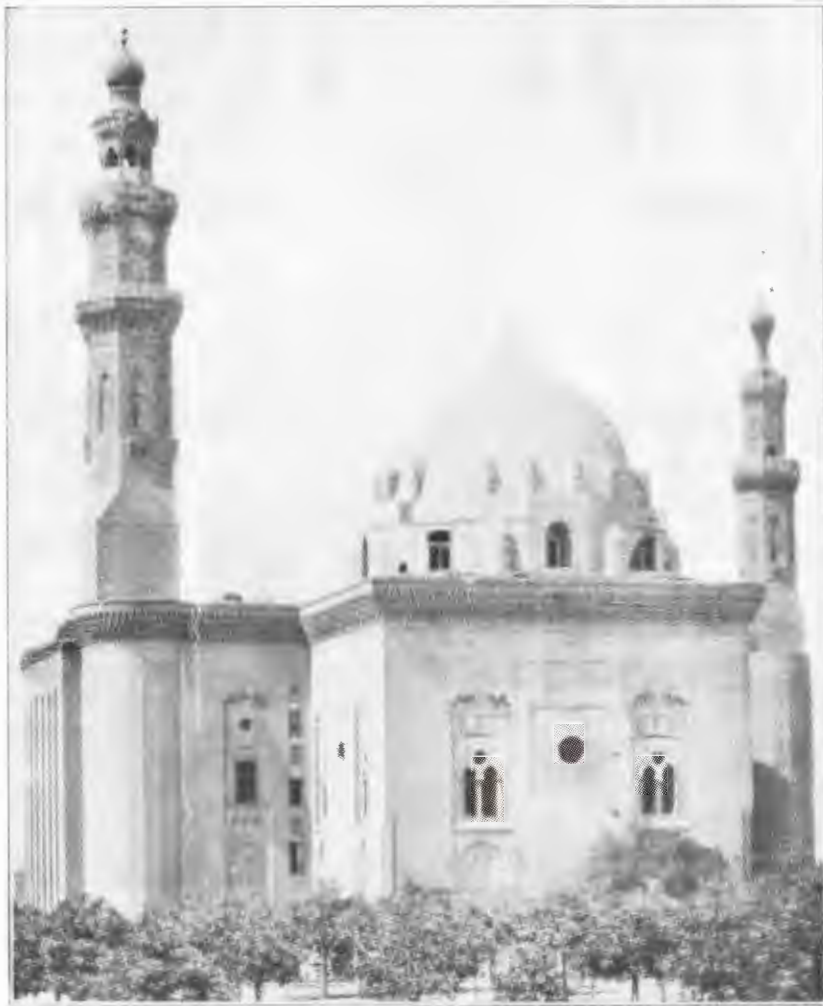
پیکر ۱۸- مسجد سلطان حسن در قاهره - در سمت چپ مناره بنا مرکب از سه طبقه چند ضلعی که روی یک پایه مربع با یالهای مثلث شکل استوار شده است. گنبد بنا بر روی پایه‌ای هشت ترک با هشت پنجره نورگیر ساخته شده است
