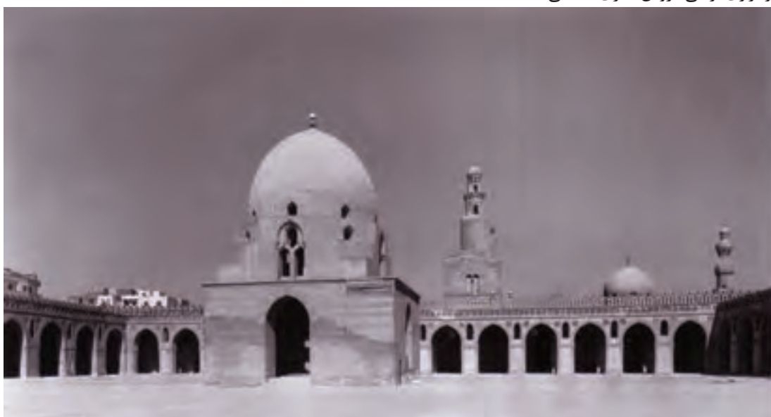
۱۰-۷- مسجد ابن طولون ، فسطاط ، نمای کلی ، ۲۶۶ هجری
